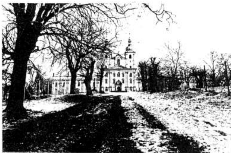
Průhled alejí na průčelí kostela Navštívení Panny Marie.
